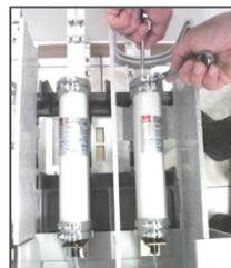
3. Заверните болт клипсы предохранителя
