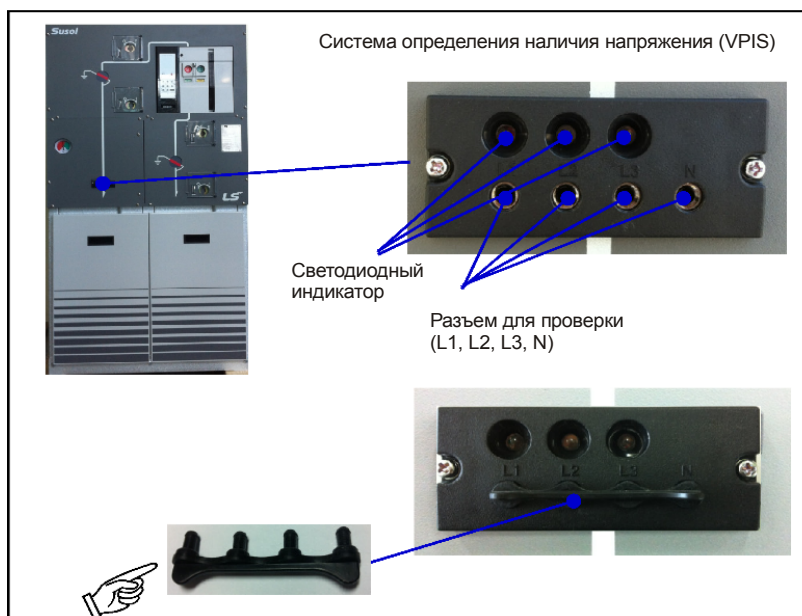
[Рис. 14-1] Проверка изделия после подачи питания
