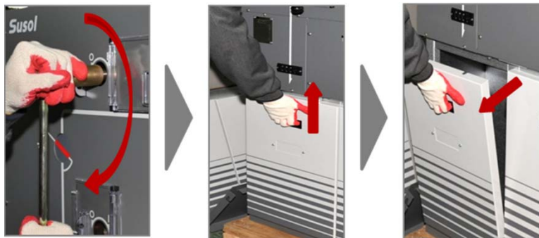
[Рис. 10-2] Открытие кабельного отсека функции L
