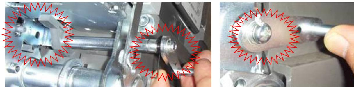
5. Выставьте положение штока таким образом, чтобы блокирующая планка штока доходила до планки отключения выключателя. После того как шток установлен правильно и ничего не мешает его ходу, зафиксируйте положение блокировочного штока стопорной шайбой
