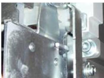
8. Сделайте прорезь во фронтальной крышке выключателя под блокировочные тяги, как показано на фото, затем установите крышку на место:
